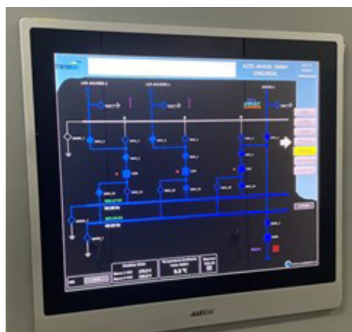
Schema linea singola generale su touchscreen
